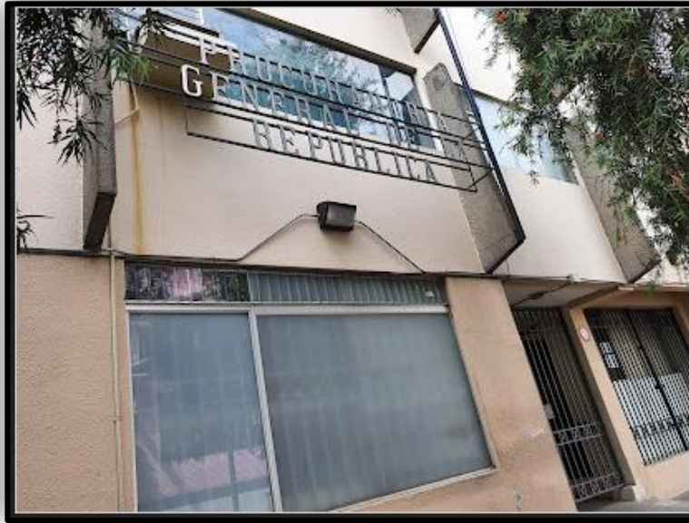
Imagen 2: Vista fotográfica de la ubicación de las Instalaciones del Edificio Principal de la Procuraduría General de la República, fuente google maps tomada en noviembre 2024.
